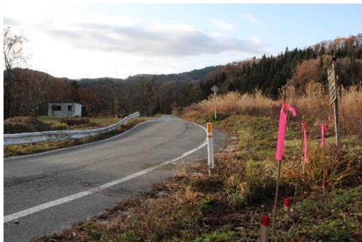
測量が始まった県道49号線（黒滝不動尊入口付近）
